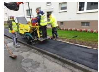
A1920_Deckschicht.jpg Wer will da noch per Hand einbauen? Glatt und schnell verläuft auch der Einbau der 4 cm starken Deckschicht mit dem Mini-Fertiger AFW 150-2 von Ammann.
