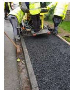
A1920_Tragschicht.jpg Die 80 cm breite und 6 cm starke Tragschicht sind mit dem Mini-Fertiger AFW 150-2 von Ammann schnell erledigt.
